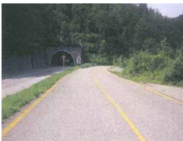
Fig. 8 – Il tratto interessato dai lavori.
