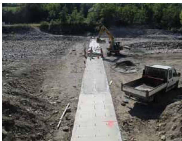
Fig. 11 – L'alveo del fiume ripristinato.
